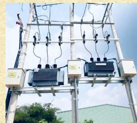
Lắp đặt MBA tại TP.Hồ Chí Minh Installing Transformer in Ho Chi Minh City
