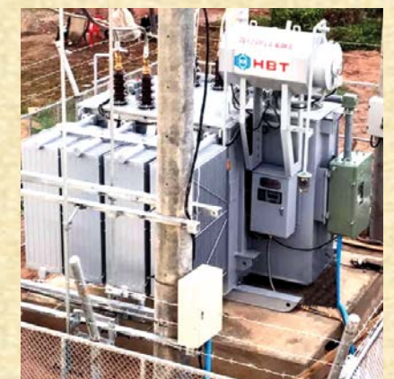
Lắp đặt MBA 25 MVA tại Campuchia Transformer 25 MVA is installed in Cambodia
