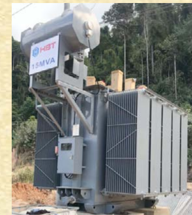
MBA 15 MVA lắp tại Lào Installing Transformer 15MVA in Laos
