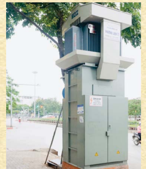
Lắp đặt trạm trụ hợp bộ tại Hà Nội Installing composite station in Ha Noi
