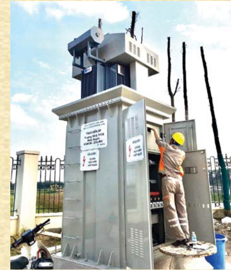
Lắp đặt MBA tại miền Bắc Installing Transformer in the North
